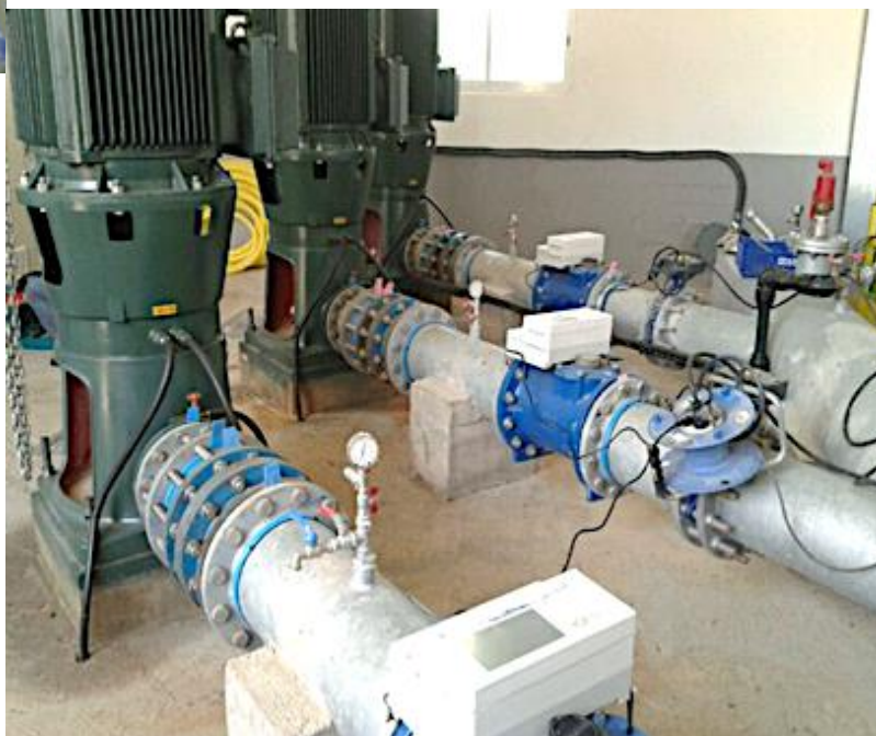
Equipos en sala de bombeo para riego tuberías de 250mm
